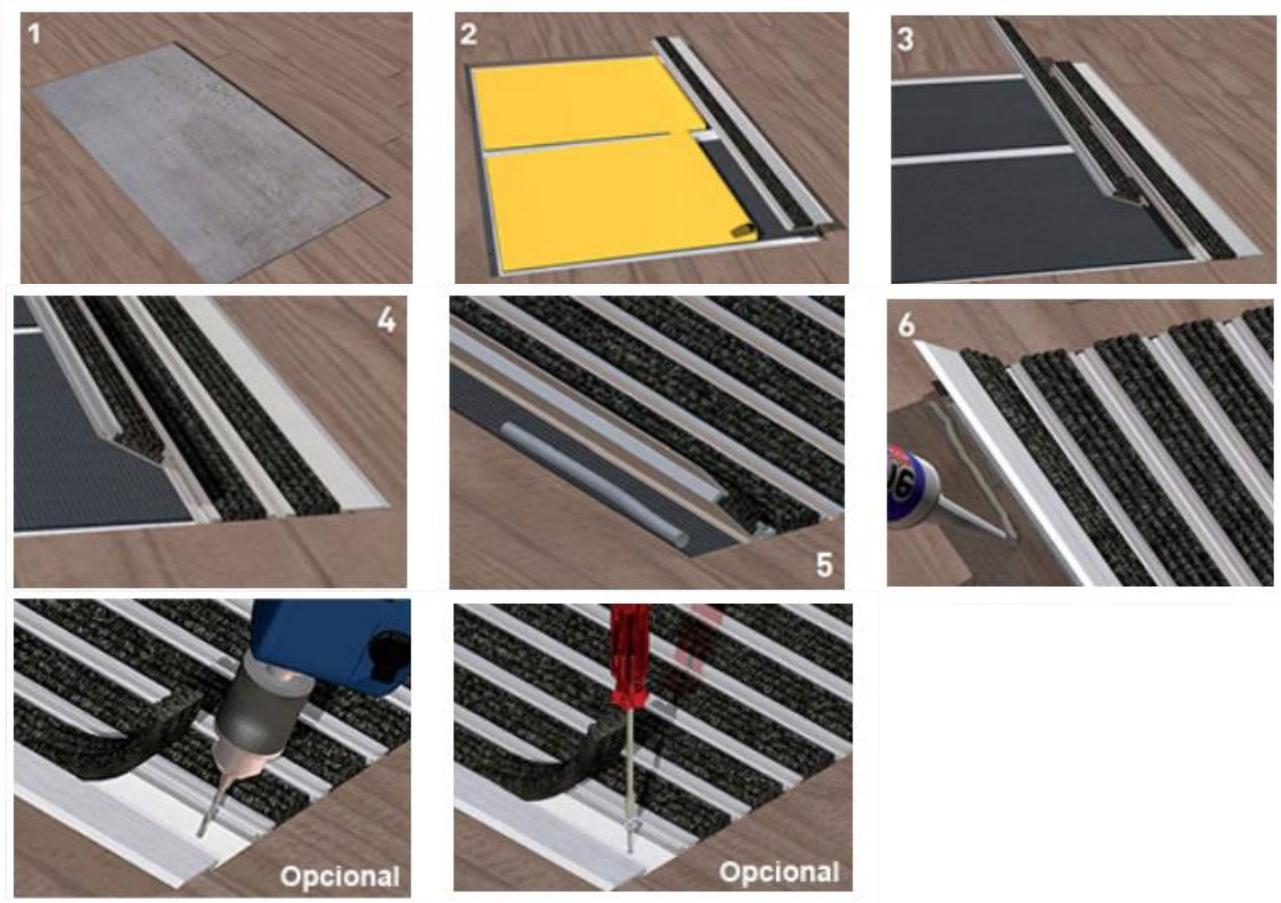
1.2 Coloque as tiras de espuma com a face auto-adesiva para cima e perpendicular aos perfis de alumínio. Remova parcialmente o papel protetor do adesivo. As tiras localizadas nas extremidades devem ser colocadas a uma distância máxima de 5 cm da borda e no mínimo de 2 cm para permitir a colocação do ângulo de parada, se necessário. Deixe o perfil com a marca Basmat para o final.
